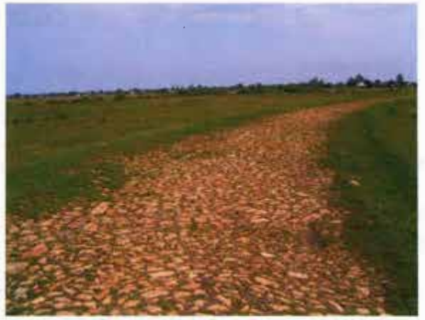
Фрагмент гранитной дороги.
